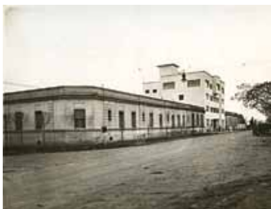
Las obras del cuerpo Central del Hospital, base de su fachada actual, se retomaron recién en 1935 y abarcaban un ambicioso proyecto que incluía tres pisos.
