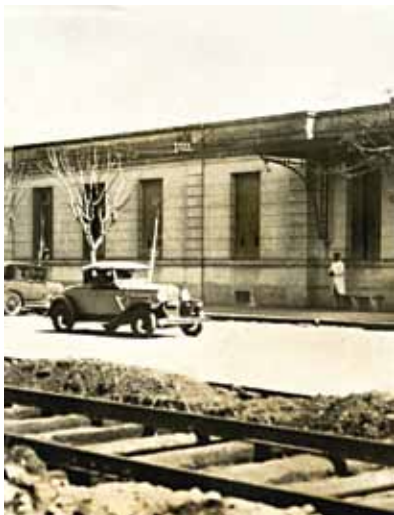
Antigua fachada del Hospital. Además de los automóviles de la época, la fotografía muestra uno de los grandes avances urbanos que acercó a este centro de salud a los vecinos: las vías del tranvía.
