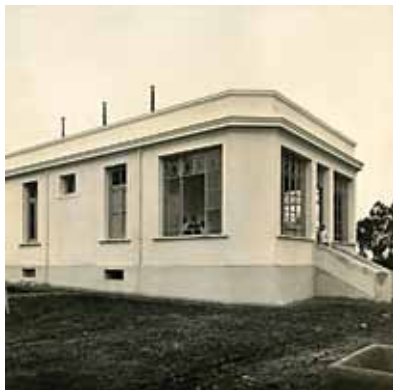
Durante las primeras décadas del Siglo XX, se anexaron diversos pabellones al edificio original gracias al aporte de importantes miembros de la colectividad italiana.
