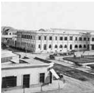
La estación “19 de noviembre”, actual Pasaje Dardo Rocha, fue inaugurada en 1888 y cumplió su función hasta 1906, cuando se inauguró la nueva terminal en la esquina de 1 y 44.
