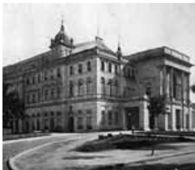
Antigo Teatro Argentino, destruido por un trágico incendio el 18 de octubre de 1977.
